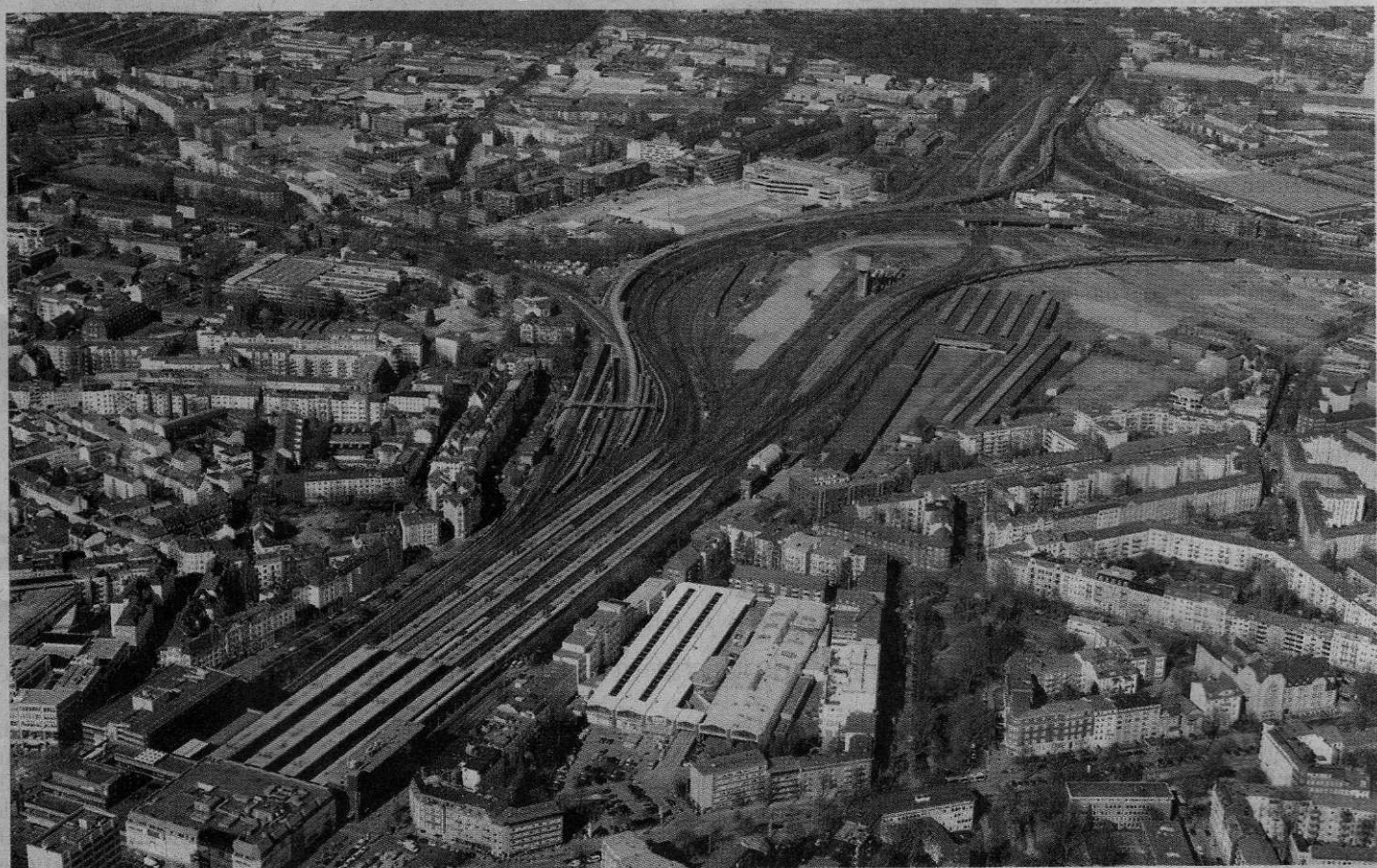
Darum geht es: Von unten links soll der Fernbahnhof nach oben rechts umziehen Foto: Matthias Friedel Luftbildfotografie/BSU/dpa
